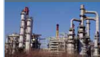
Um halbwegs gereinigte Abgase zu erreichen, werden den Schornsteinen aufwändige und kostenintensive Anlagen/Filter zur Rauchgaswäsche und -reinigung vorgeschaltet.
