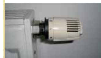
Mit Hilfe eines Thermostats kann man in jedem Raum eine individuelle Temperatur einstellen.
