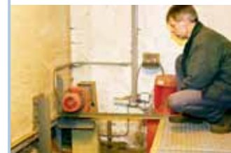
Die Nutzer von Hackschnitzelanlagen sind nicht von steigenden Heizölpreisen abhängig.
